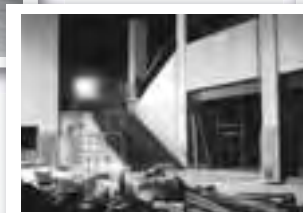
見慣れたホールも工事中
